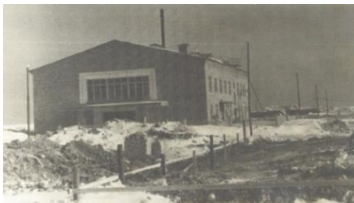
Здание Сыктывкарского телецентра, март 1963 г.
